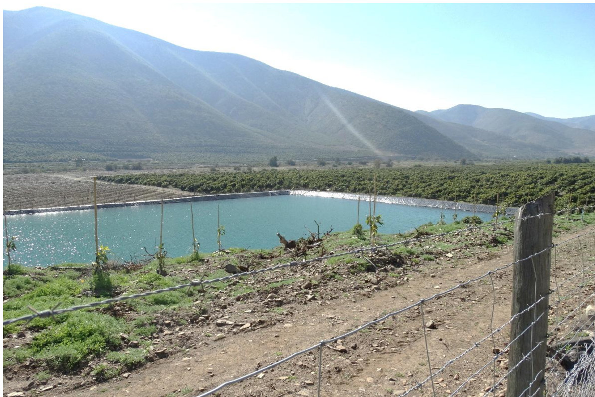
Fotografía n°4: Tranque de acumulación. Fuente: imagen propia.
